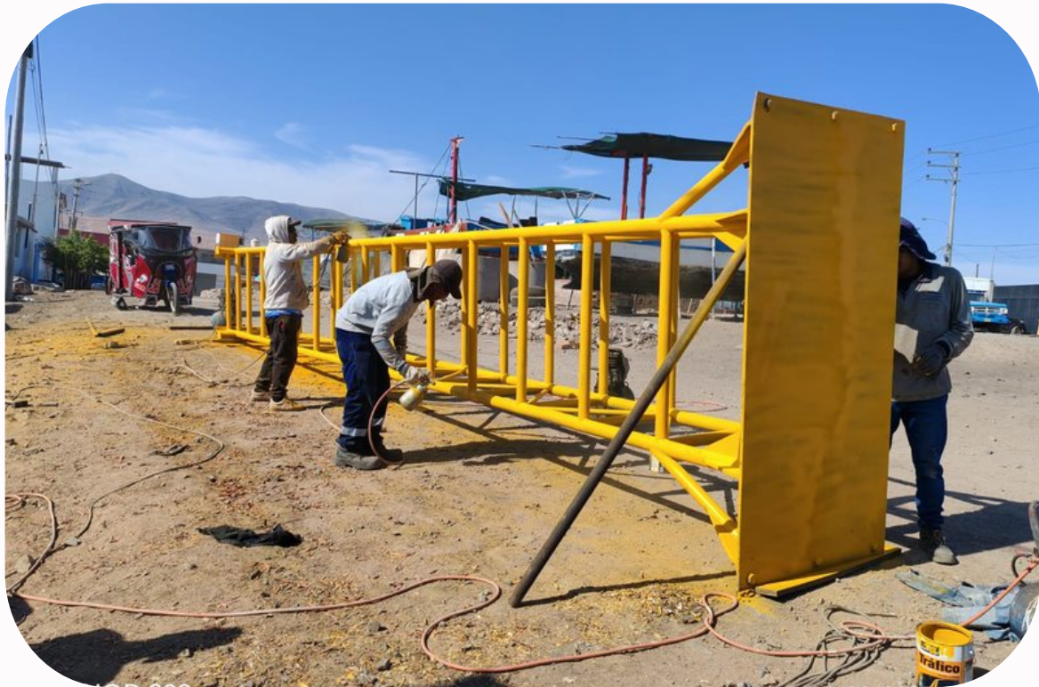
MANTENIMIENTO DE RASTRA METALICA - MOLINOS - ISLAY - 2025
