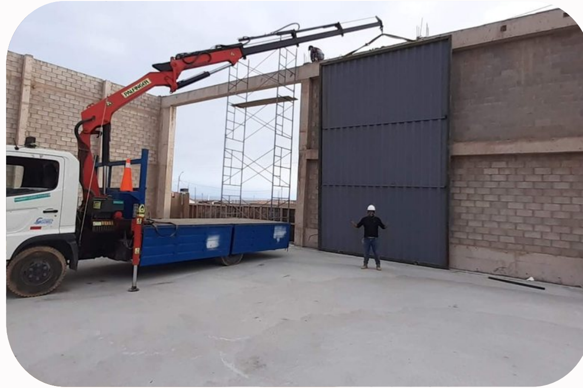
FABRICACION Y MONTAJE DE PORTONES CORREDIZOS EN ALMACENES PERUANOS CEMENTOS RUPHA - ISLAY 2020
