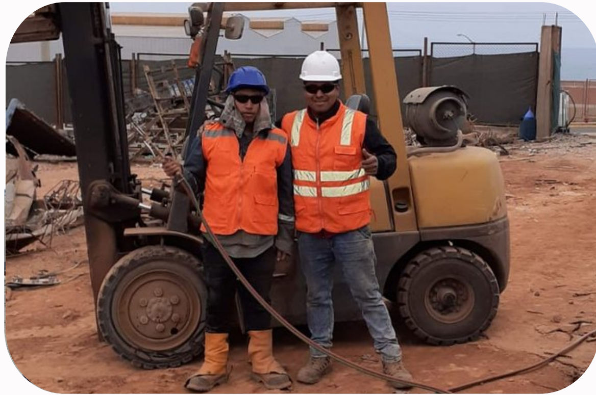
TRABAJOS DE OXICORTE EN ZED MATARANI - ISLAY - 2024
