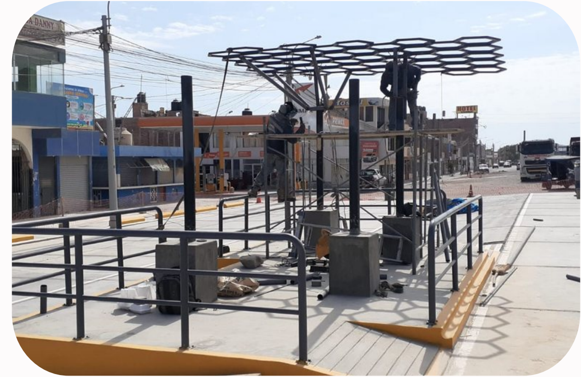
CONSTRUCCION DE PARADEROS Y ESTACIONAMIENTO EN EL MERCADO MODELO DE ATICO - 2021
