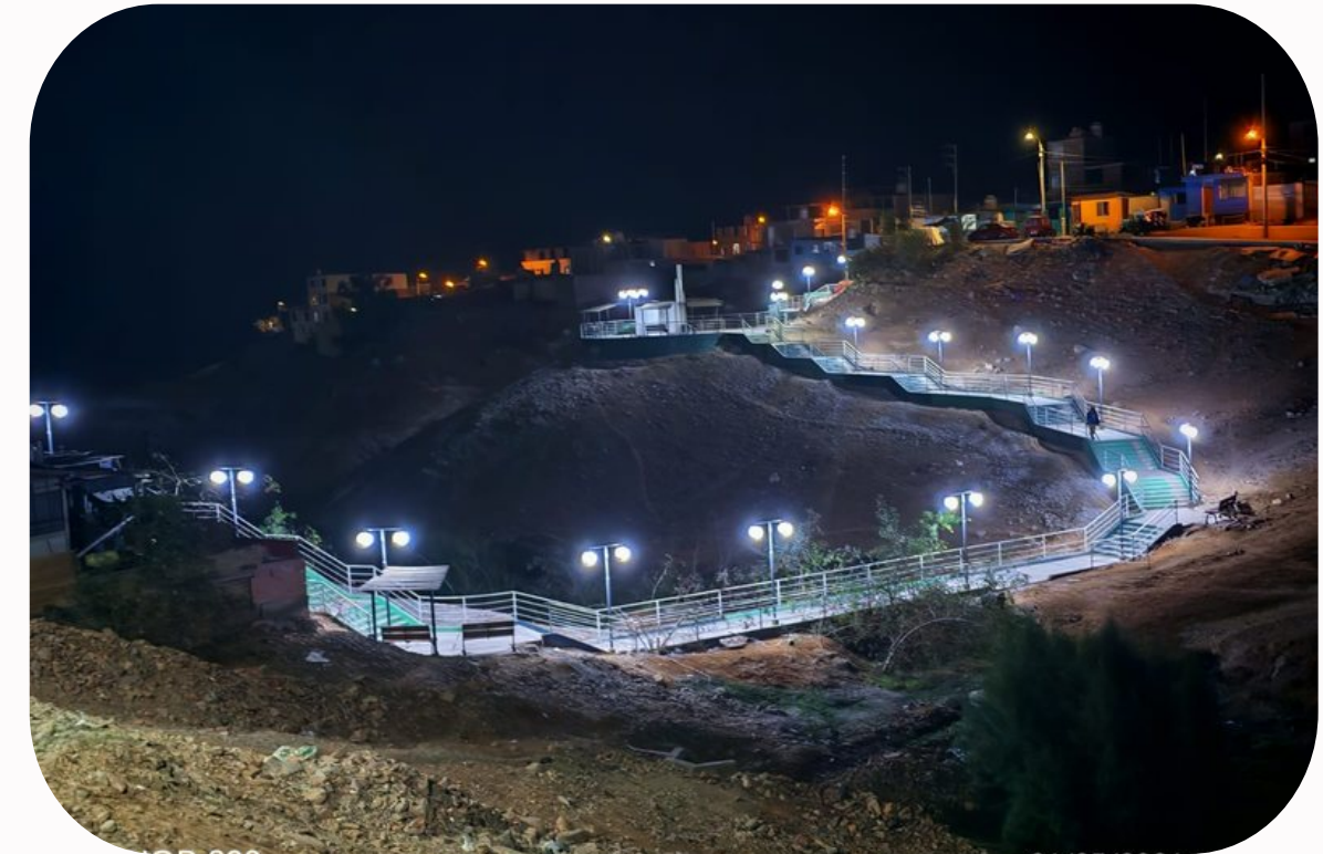
INSTALACION DE CONEXIONES ELECTRICAS PARA LA IOARR ADQUISICION DE LUMINARIA; EN LA VIA PEATONAL ENTRE LA APVIS MONTERRICO Y LAS PREDERAS - ISLAY - 2026
