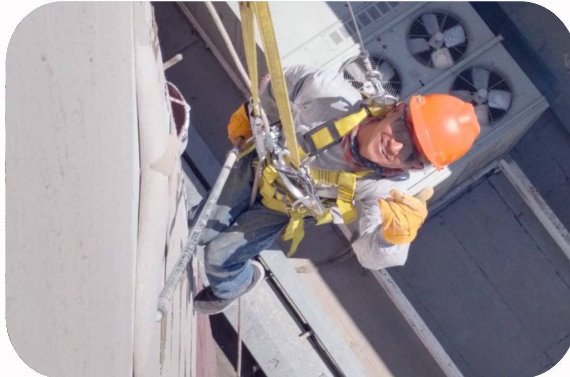
TRABAJOS EN ALTURA DE PINTURA DE FACHADA EN CINEMARK - MALL AVENTURA PLAZA - AREQUIPA - 2023
