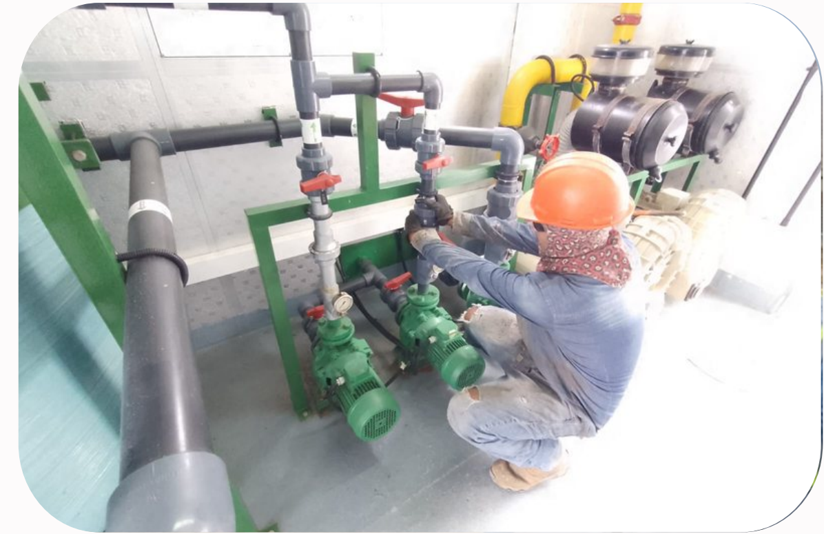
MANTENIMIENTO DE BOMBAS DE CAUDAL EN LA PETAR DE MEJIA - 2024
