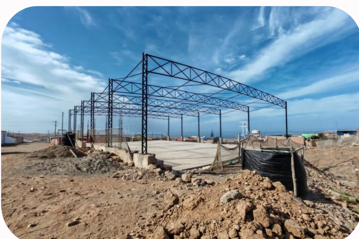
CONSTRUCCION DE ESTRUCTURA METALICA PARA COBERTURA DE LOZA DEPORTIVA DE ADEMYPE - ISLAY - 2025
