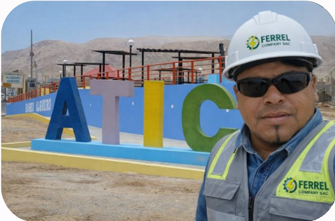
CONSTRUCCION DEL PARQUE RECREACIONAL BARCO ALGUERO EN LA FLORIDA ATICO - CARAVELI - 2022
